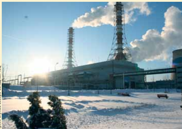
Пресс-служба Северо-Западной ТЭЦ
